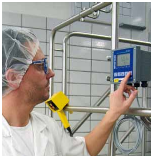
Installation d'un transmetteur pH METTLER TOLEDO
