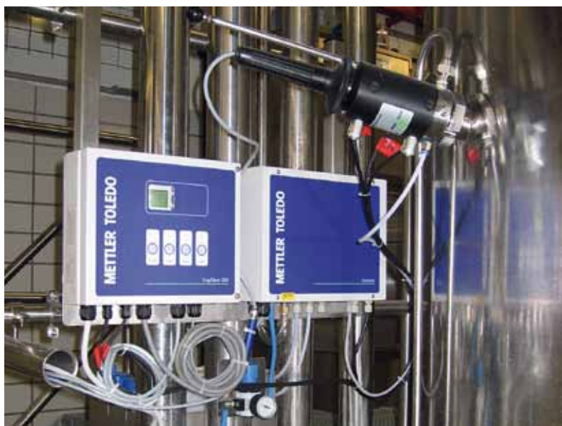
Le système de nettoyage et d'étalonnage EasyClean, électrode pH InPro 3300/ISFET
