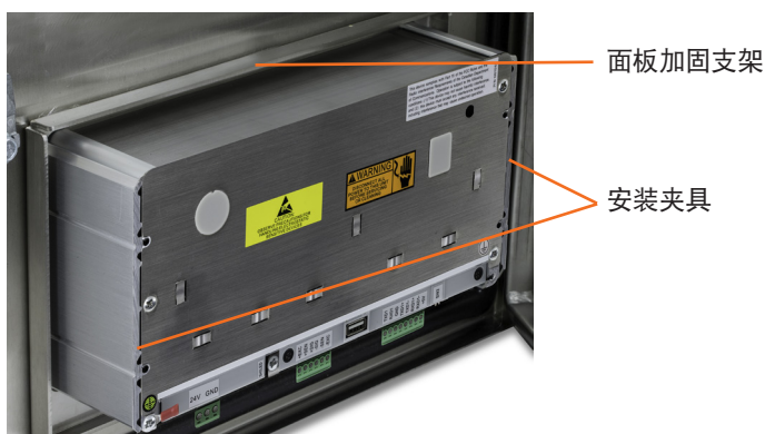
图 2-5: 安装后的面板加固支架
